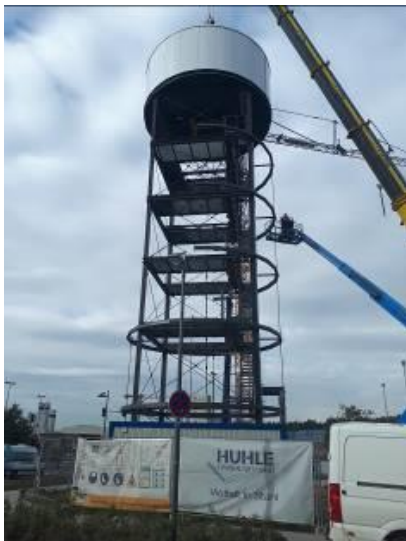
Eine Stahlkonstruktion mit zahlreichen Schraubverbindungen und rund 150 Schweißnähten, für die mit dem Schweißkantenformer TKF 1500 von Trumpf metallisch blanke Fasen erzeugt wurden, bilden die solide Basis für den Kion-Tower.
