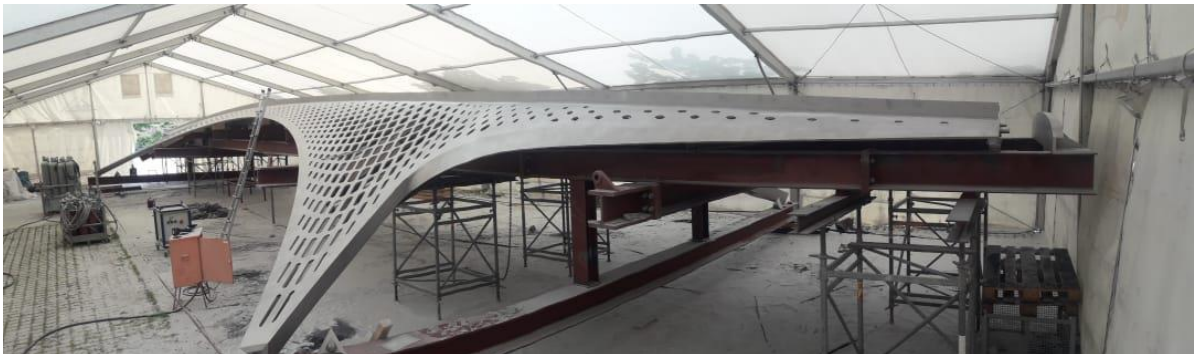
Das Brückenbauwerk wird in einem Zelt für die Montage vorbereitet. Fotos: Prebeck
