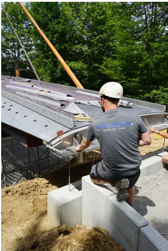
Die Brückenden werden auf die Widerlager aufgelegt.
