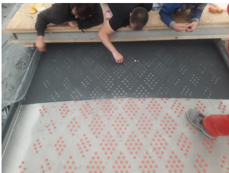
Die 14.300 Glasstopfen wurden in mühevoller Handarbeit eingesetzt.
