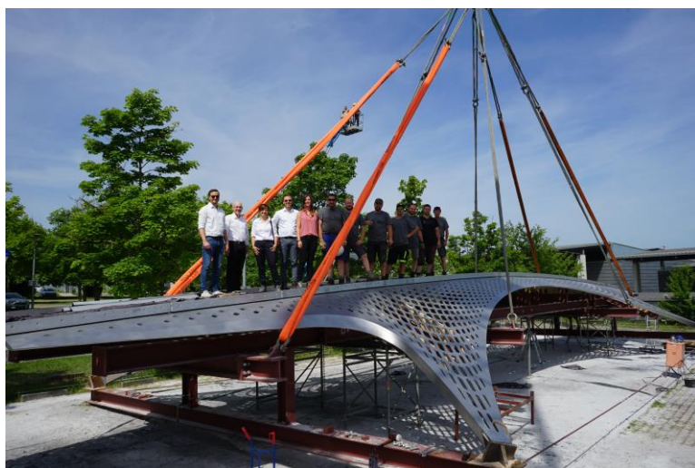
Vor dem Einschwenken mit den Kran.
