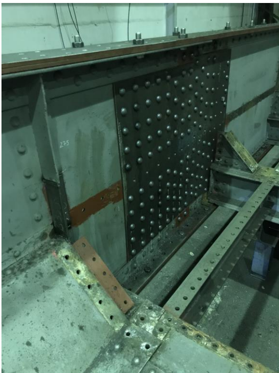
Es entsteht ein sauberes Nietbild.
