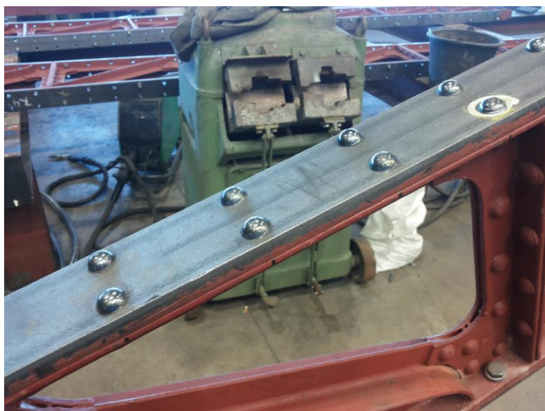
Eine sauber ausgeführte Nietverbindung bei einer Restaurierung.
