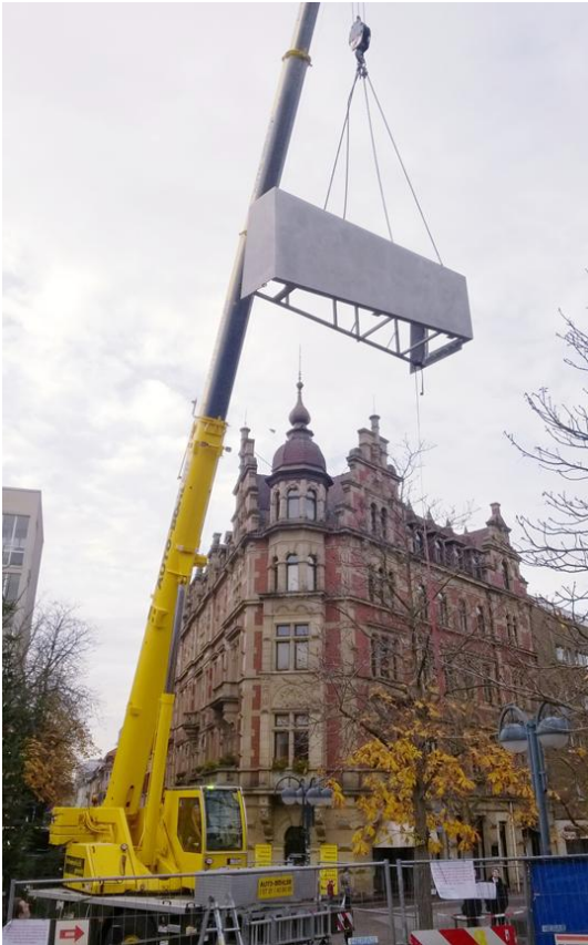
Eine Kranmontage der weitgehend vorgefertigten Teile war erforderlich.
