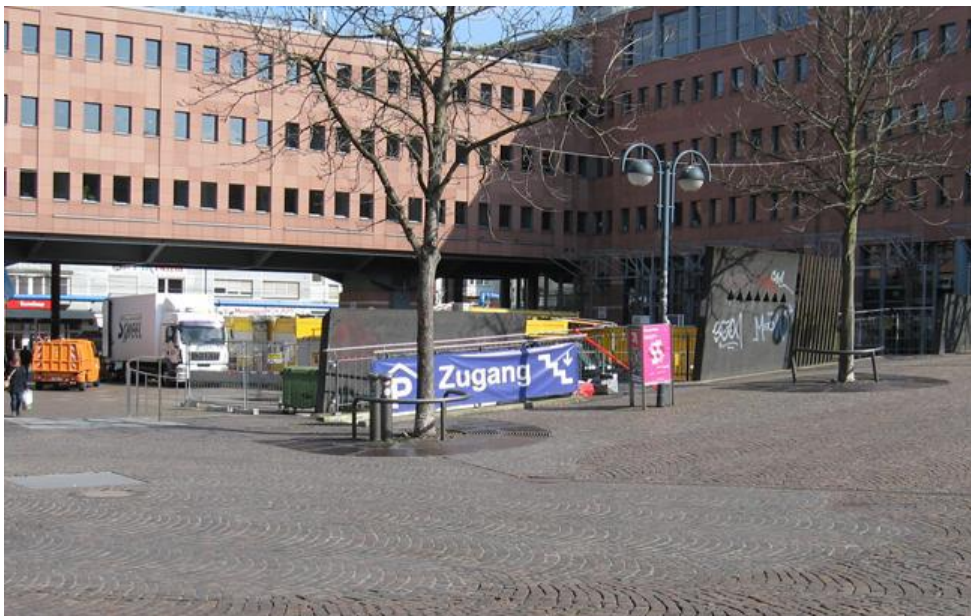
Eine Aufwertung des Eingangs zu der nun öffentlichen Tiefgarage schien unbedingt notwendig.
