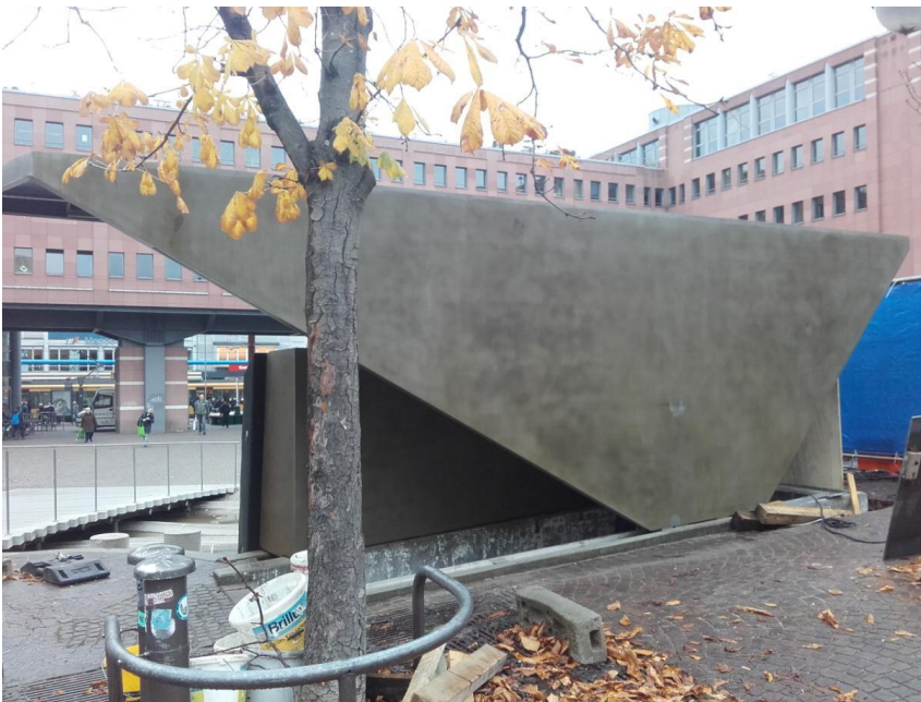
Wegen der beengten Platzverhältnisse und des knappen Zeitfensters war eine detaillierte Montageplanung notwendig.
