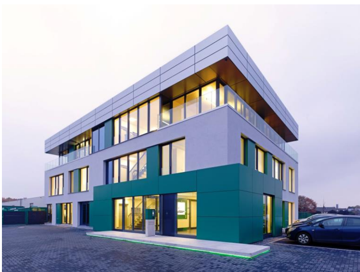
Die Fassadenbekleidungen wurden alle auf dem neuen Biegezentrum gefertigt.
