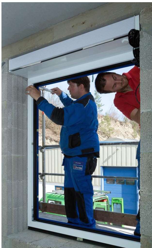
Montage des vorbereiteten Fensters, wie bei einem Rollladen-Aufbauelement.
