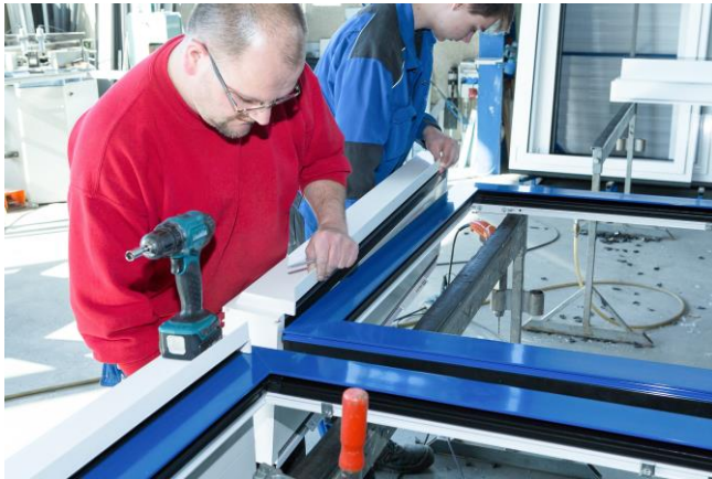
Aufsetzen der Endura Twist auf den Alu-Fensterrahmen. Fotos: Renson
