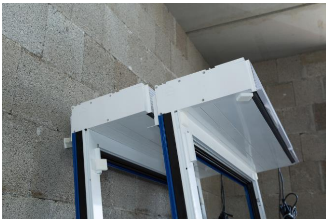
Vormontierte Fenster mit Endura Twist, quasi wie ein Rollladen-Aufbauelement.
