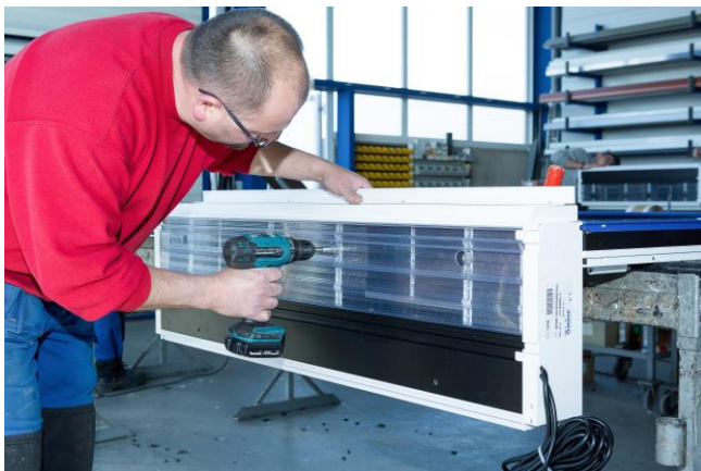
Verschrauben der Endura Twist durch die gelochten Stege hindurch mit dem Fensterrahmen.
