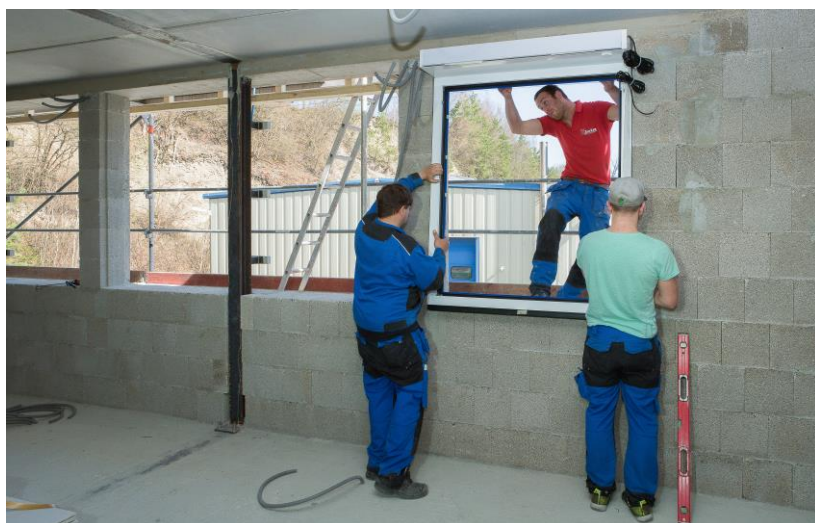
Montage des Alu-Fensters mit aufmontierten Endura Twist.
