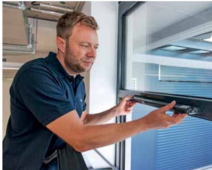
Das Smart fix-Montagesystem: Einfache und schnelle Antriebsmontage auch in schwierigen Einbausituationen.
