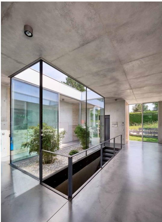
Auch der Lichthof wurde mit cero realisiert. Die Verglasung setzt einen Kontrast zum Sichtbeton.
