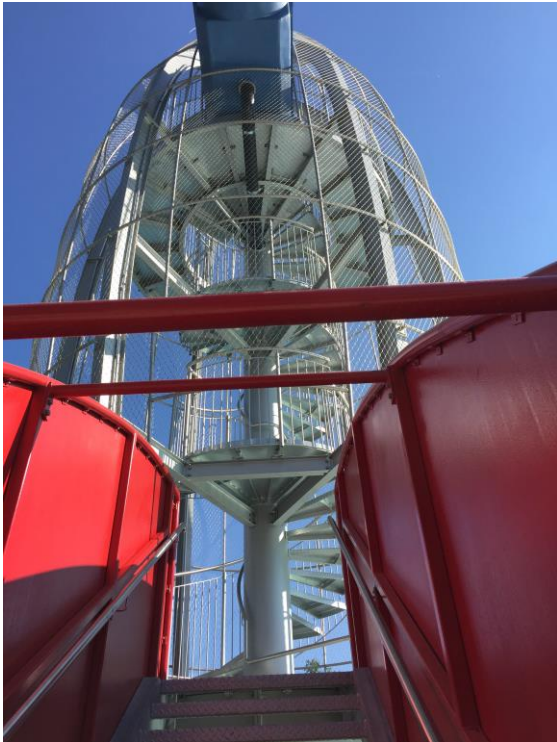
Die Treppenskulptur in Space-Outfit ist eine Mischkonstruktion aus verzinktem beschichtetem Stahl und Edelstahl.
