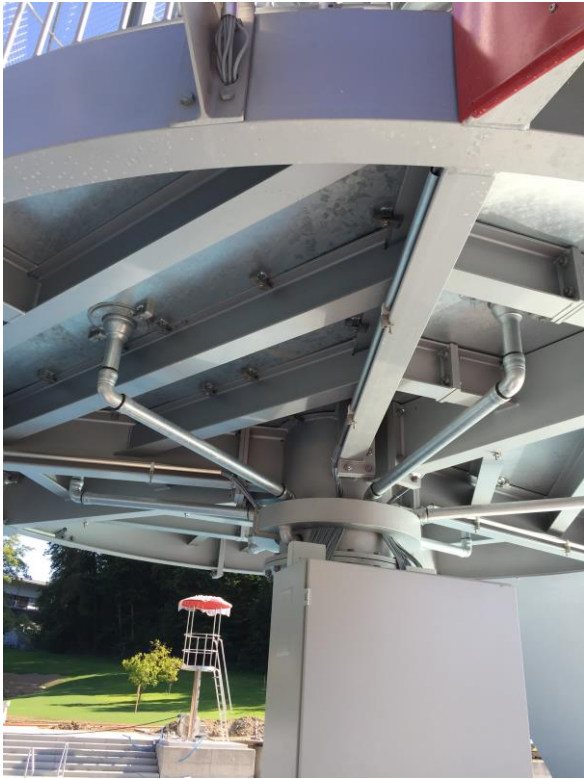
Die komplette Stahlbauplanung, Produktion, Vormontage sowie Endmontage vor Ort lag in der Verantwortung der Stahl- und Treppenbau Kuhla aus Vetschau.
