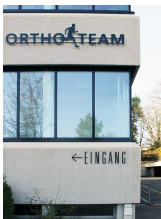
Die Fensterbänder am Geschäftshaus an der Bühlstrasse in Zollikon sind in Pionierarbeit mit dem Fassadensystem Schüco FWS60 CV realisiert worden. Foto: Schäublin Architekten
