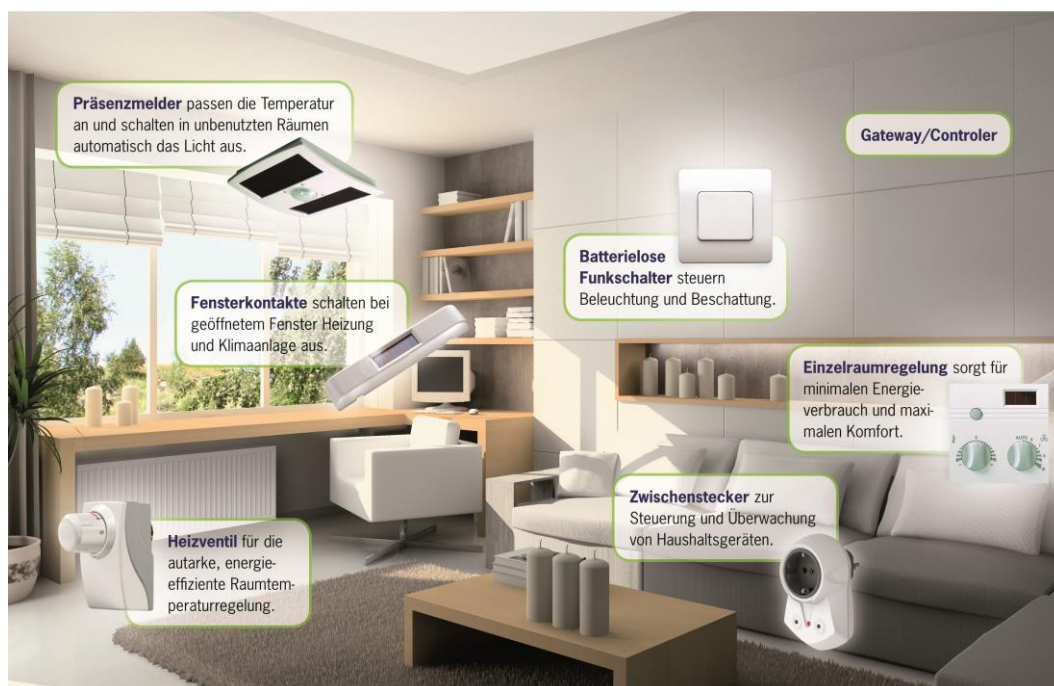
Sensoren von EnOcean brauchen keine Batterie. ( www.enocean.com/de/anwendungen-im-internet-der-dinge/smart-home-und-heimautomation/ )
