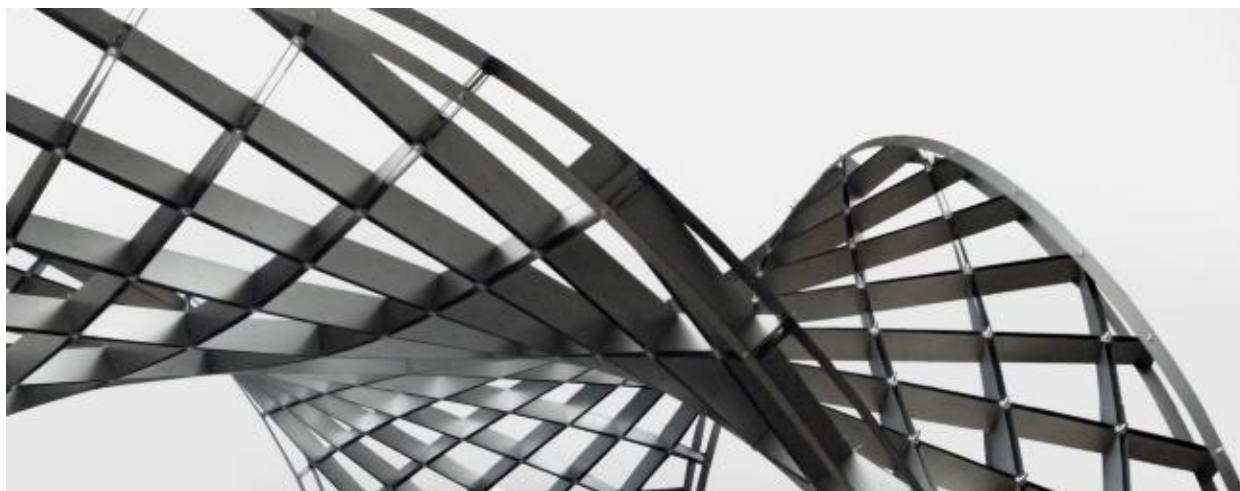
Zuerst wurde ein Prototyp aus drei Millimeter dicken Holzlamellen gebaut. Die beiden Scharen verlaufen in zwei Ebenen und sind durch Quadratbolzen miteinander gekoppelt. Foto: Eike Schling
