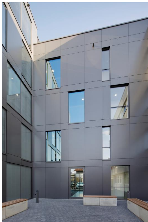
Ein Verbindungsbau mit dominanter Aluverkleidung verknüpft den Bestand mit dem Neubau. Damit von der Befestigung äußerlich nichts erkennbar ist, hat Freyler Metallbau rückseitig Bolzen aufgeschweißt.
