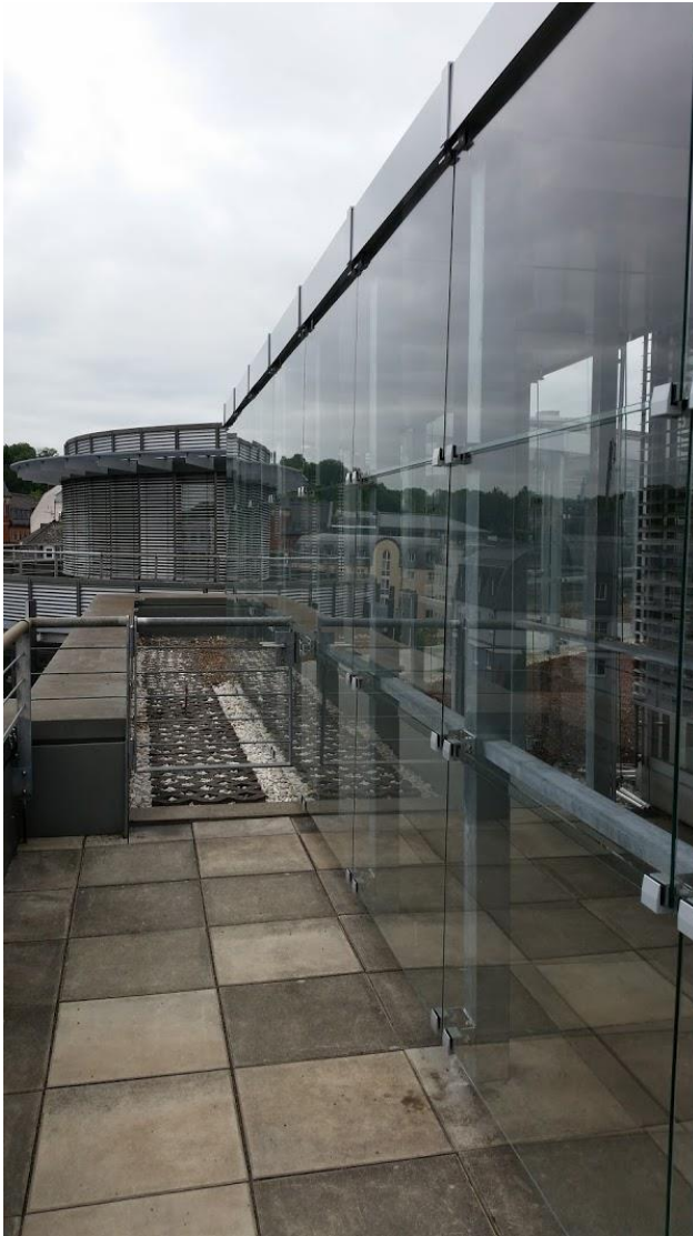
Dachübergang mit Glasbekleidung.
