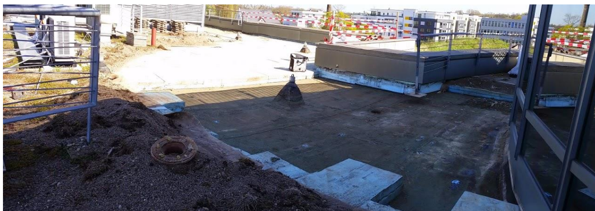
Freilegung der Dachfläche.
