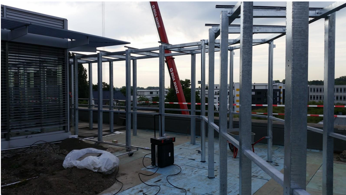
Montage der Stahlkonstruktion.
