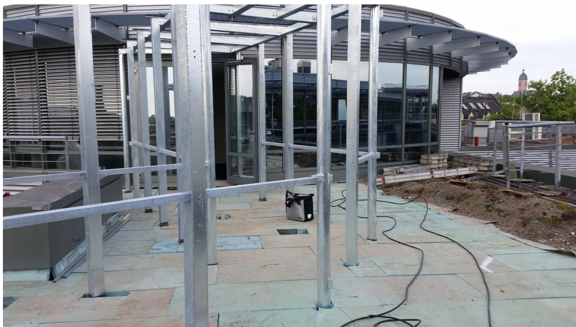
Bodenlegarbeiten für den Übergang.
