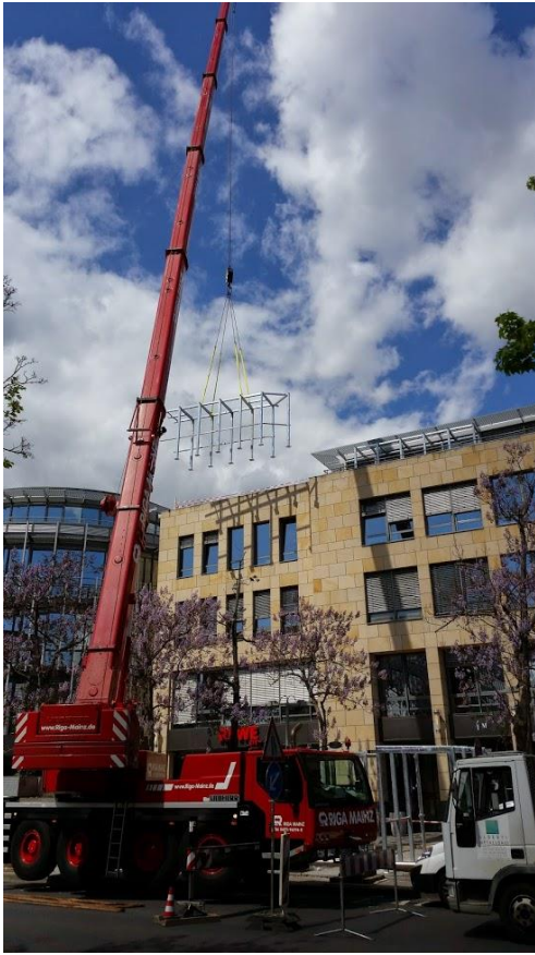
Einheben der Stahlkonstruktion.
