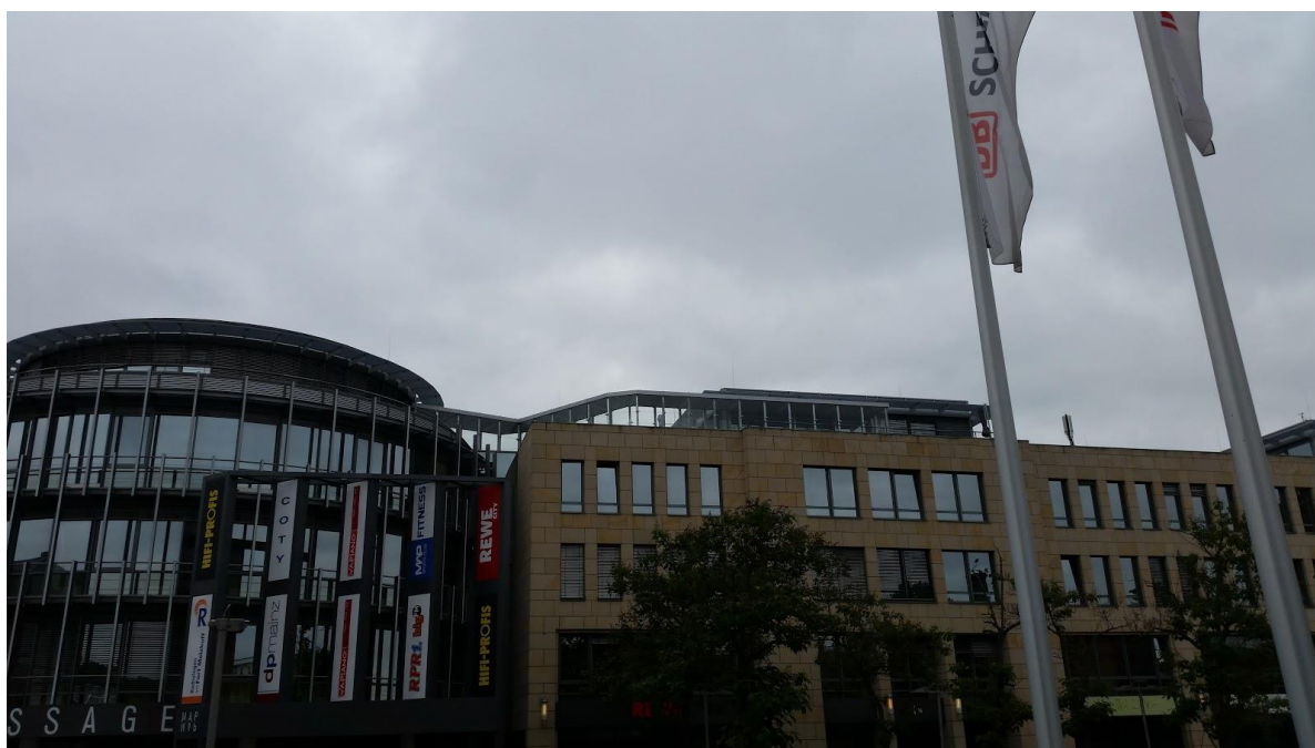
Blick auf den Dachübergang von der Straße aus.
