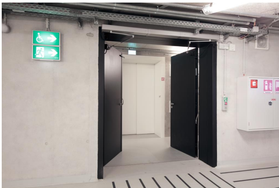
Funktionstür par excellence: Zweiflügelige Fluchttür mit Vollpanikfunktion, versorgt über eine USV-Sicherung, über Drehwinkelsensoren (Detail), gekoppelt an die Entrauchungs-Anlage. Und: elegant wie bekannt – sogar in der Parkgarage.
