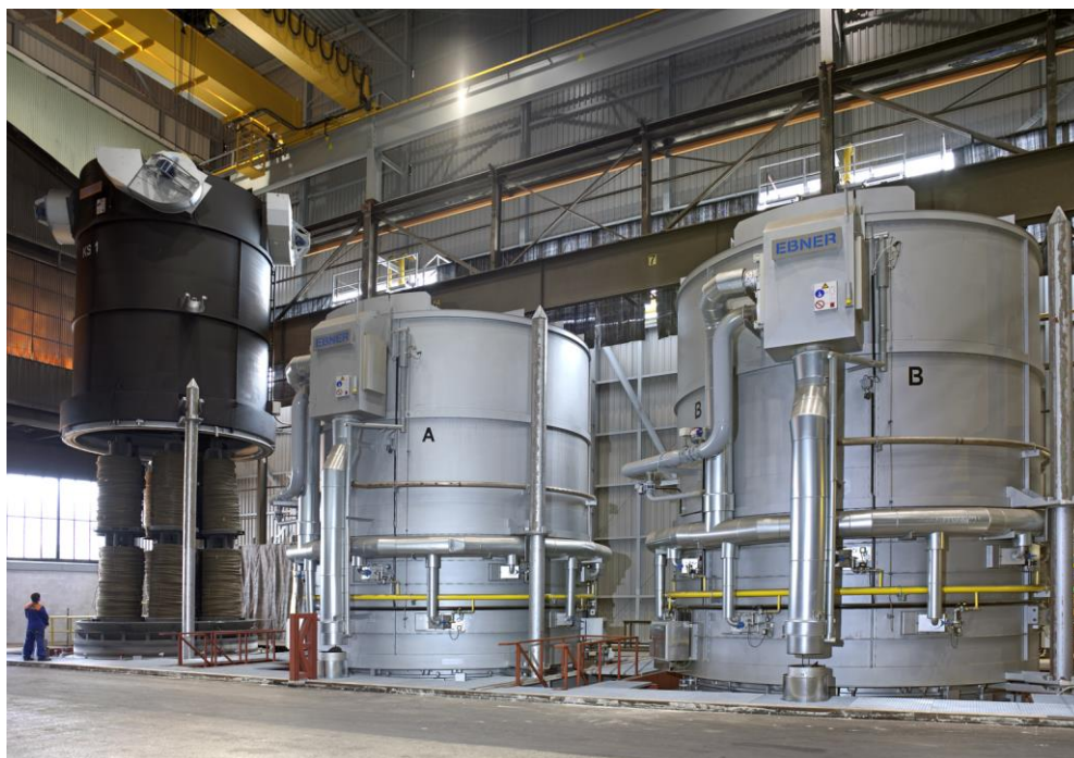
Haubenöfen des österreichischen Industrieofenbauers Ebner zur Wärmebehandlung von metallischen Produkten Foto: Ebner Industrieofenbau
