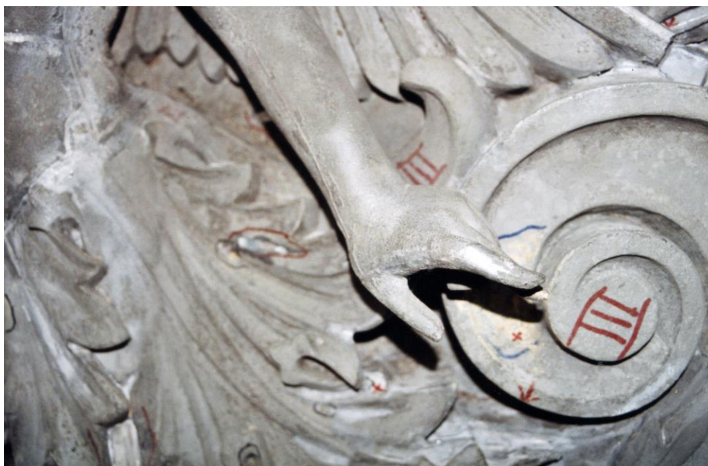
Der dünnwandig gewordene Zinkguss erhielt eine stabilisierende und stützende innere Beschichtung aus Glasseide und Epoxidharz.
