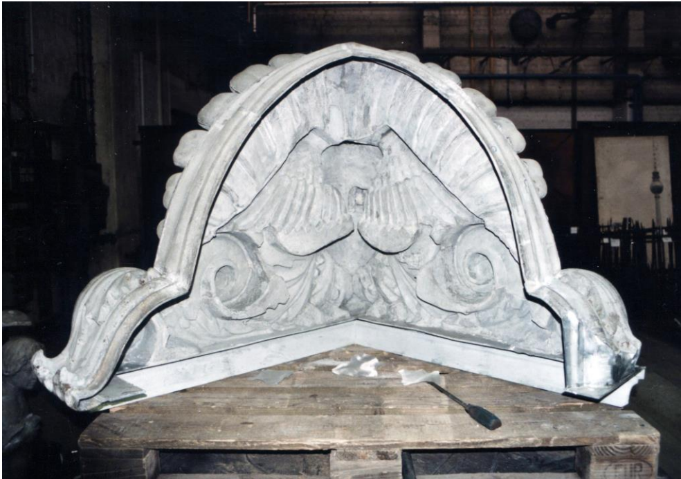
Für die Verbindung mit dem Museumsbauwerk und zur Stabilisierung wurden die Skulpturen von hinten ausgemauert.
