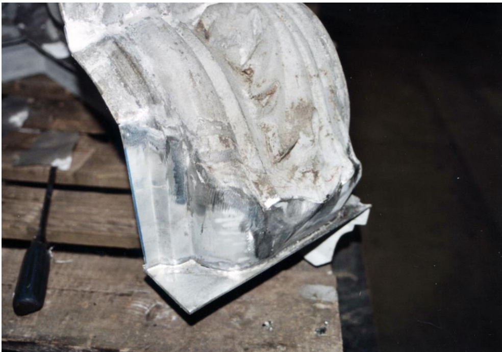
Die Reinigung der Oberfläche erfolgte vorsichtig mit Walnussgranulat. Danach wurden die Risse und Löcher mit Weichloten geschlossen.
