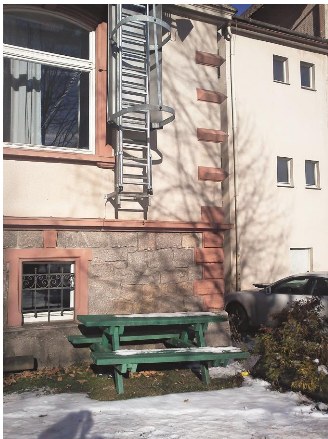
Blockierung eines Steigleiterauszugs. Fotos: Lambotte
