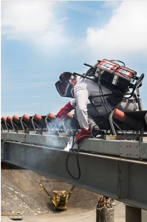
Vorteil Weld Back-Pack: Beide Hände bleiben frei für den Aufstieg und später für das Schweißen.
