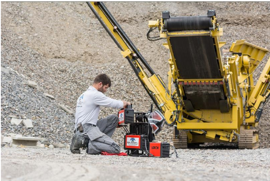
Problemloser Tausch: Bei größeren Schweißaufgaben einfach einen zweiten Akkupack anschließen.
