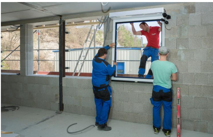
Montage des Aluminium-Fensters mit aufmontierten Endura Twist.
