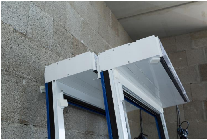
Vormontierte Fenster, quasi wie ein Rollladen-Aufbauelement.
