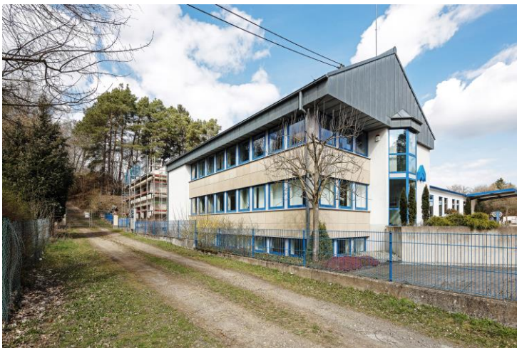
Einsatz von Endura Twist am Erweiterungsbau der Verwaltung des Bauunternehmens Augel in Weibern (Eifel).
