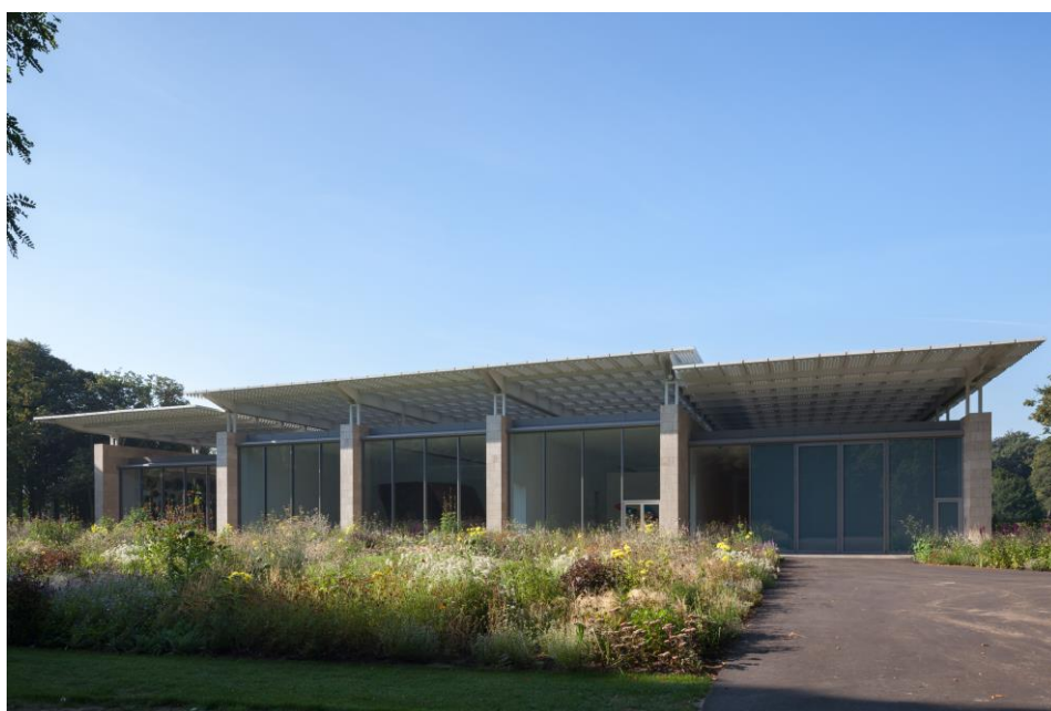
Große zweiflügelige Sicherheitsstahltür (Größe: 3.940 mal 5.260 Millimeter) mit vorgesetzter Pfosten-Riegelkonstruktion um ein einheitliches Erscheinungsbild des gesamten Gebäudes zu erzielen.
