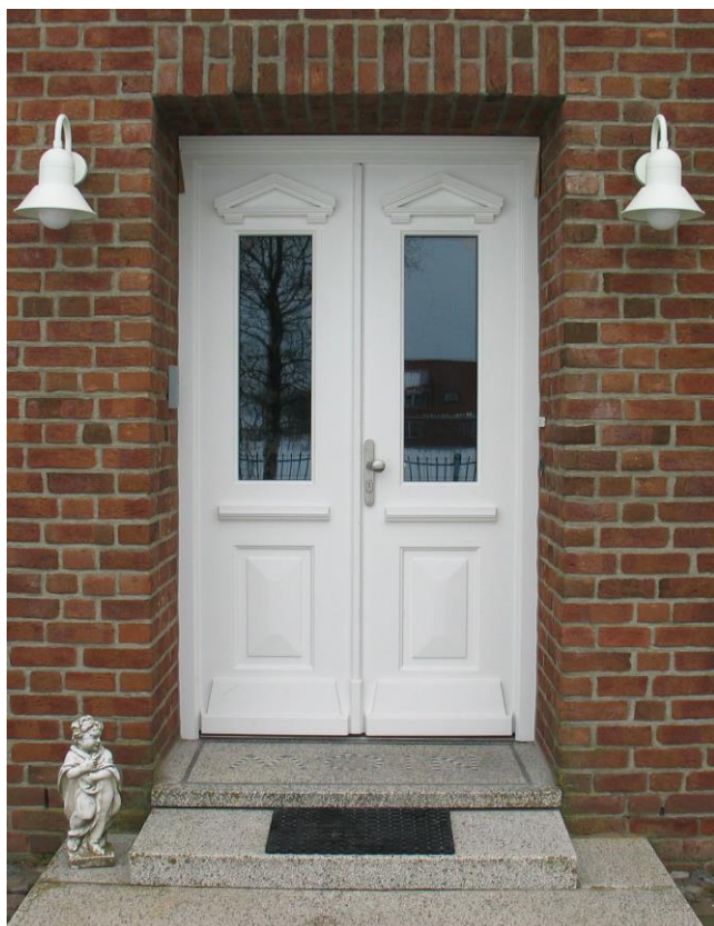
Haustür, Stahltür mit Buche beplankt.
