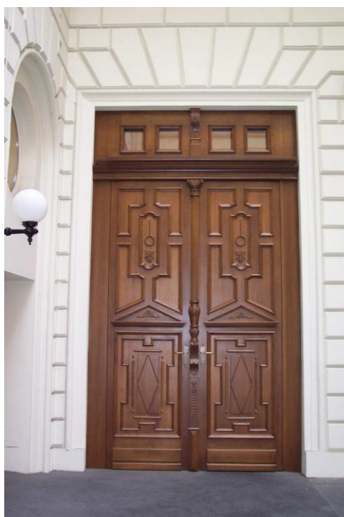
Stahltür mit Eichenholz beplankt, originalgetreuer Nachbau der historischen Vorlage, Security Upgrade, Höhe sechs Meter, mit integrierter Schlupftür.
