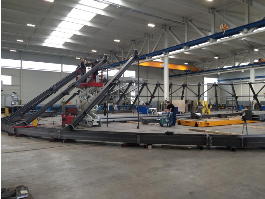
Die gesamte Konstruktion wurde in der Produktionshalle per Laser eingemessen und aufgebaut. Fotos: Hahner
