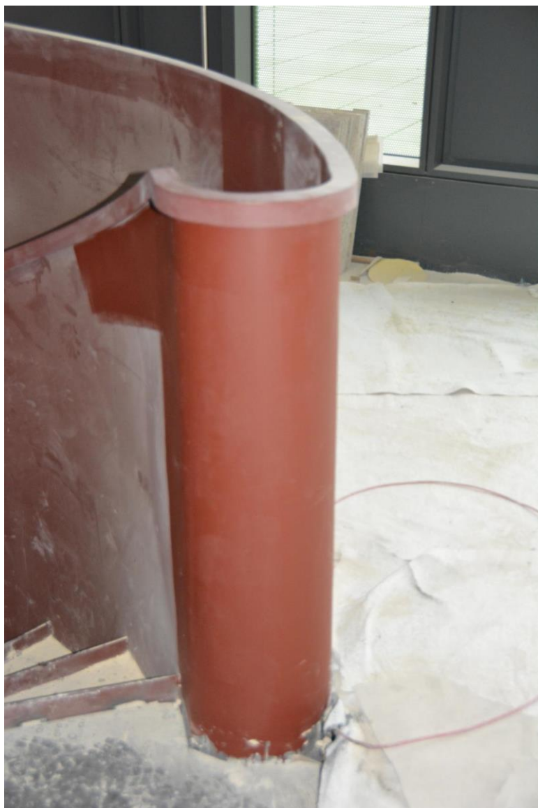
Der Radius ist zum Biegen zu eng.
