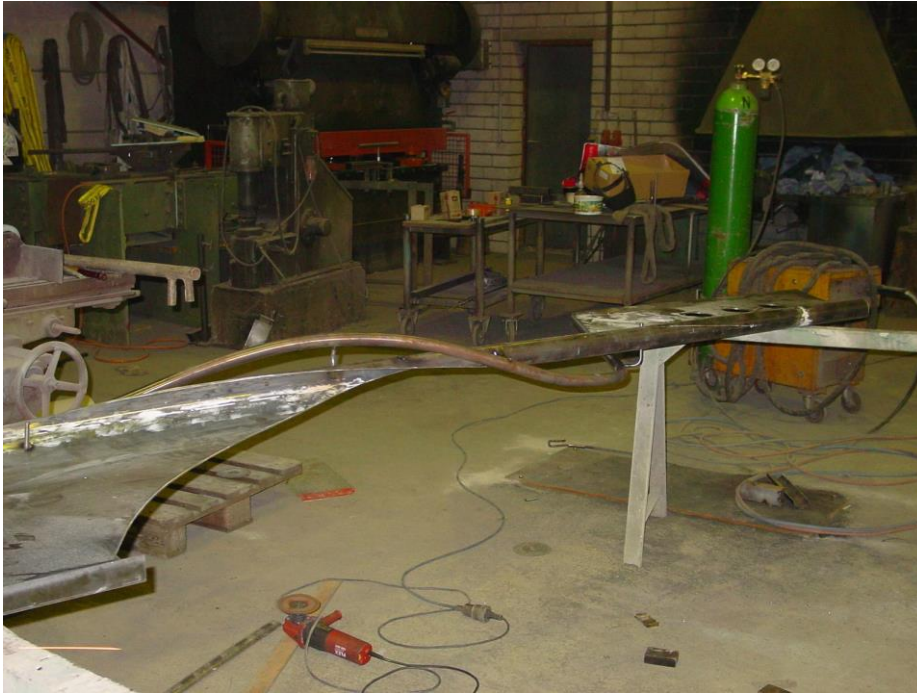
Der Handlauf wird frei gebogen...
