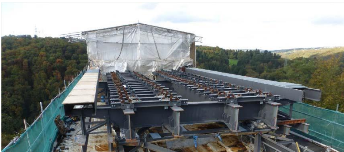
Auflagerung der Fahrbahnbrücken auf den Gerüstbrücken.
