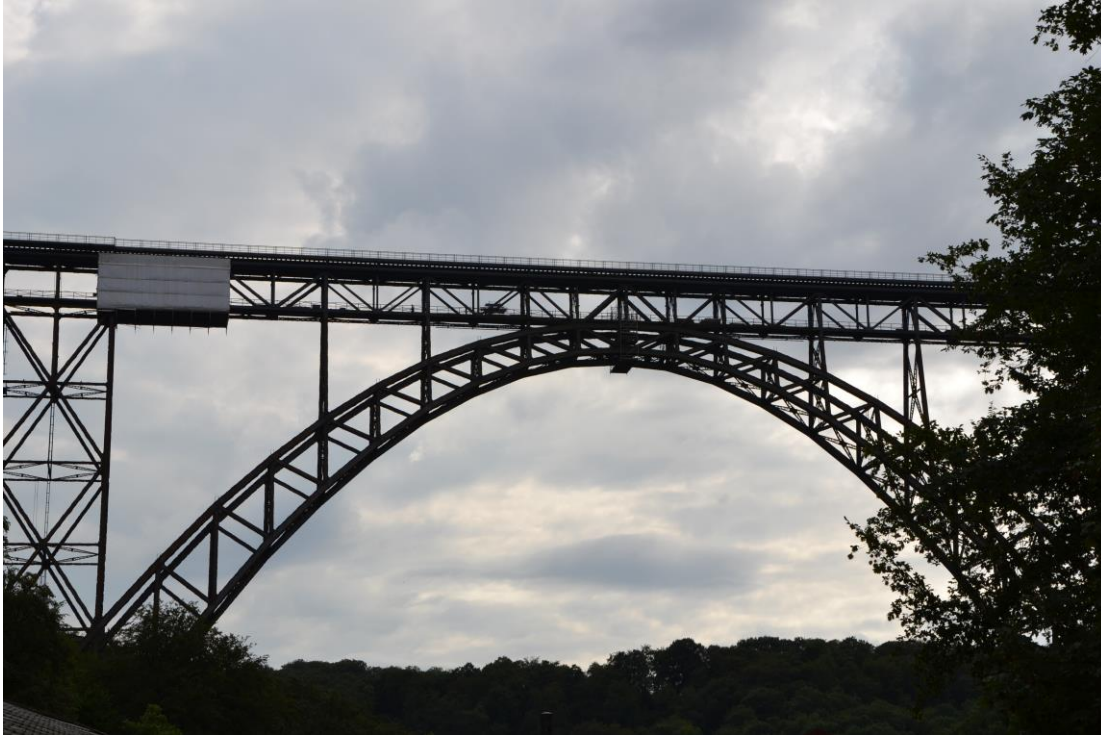
Die Müngstener Brücke musste saniert werden. Fotos: Raulf
