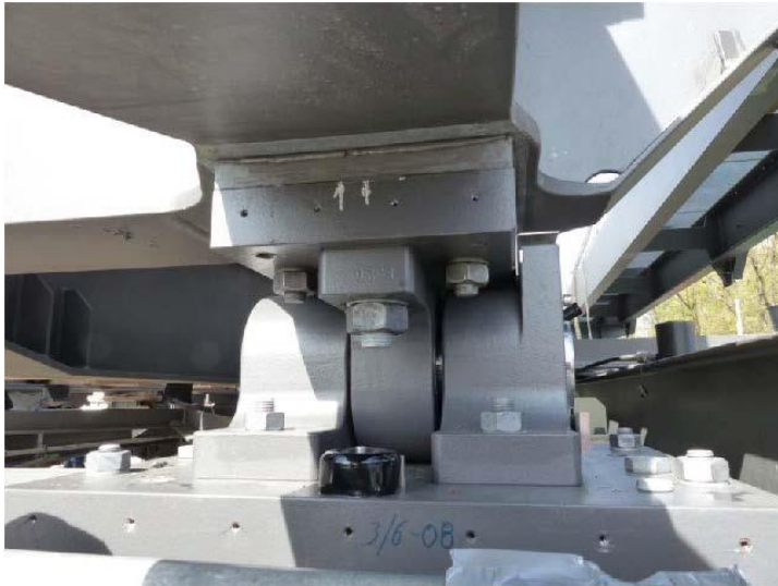
Die neuentwickelten patentierten Radialgelenklager.
