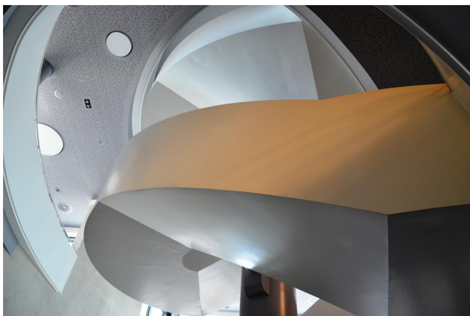
Eine Besonderheit ist die geschlossene Unteransicht durch die statisch mittragende glattflächige Stahlblechbekleidung, die passgenau dreidimensional gebogen wurde.
