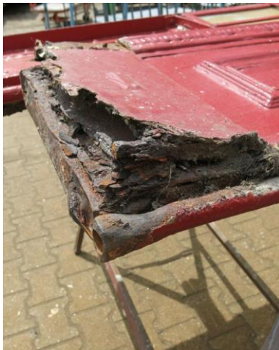
Die Macht des Urins! Die Korrosionsschäden im unteren Bereich waren kräftig.
