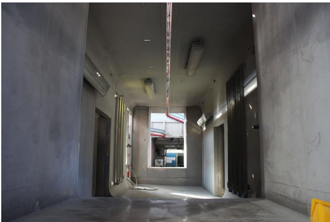
In der Reinigungsanlage werden alle Reinigungsmittel umweltfreundlich aufgefangen und entsorgt.
