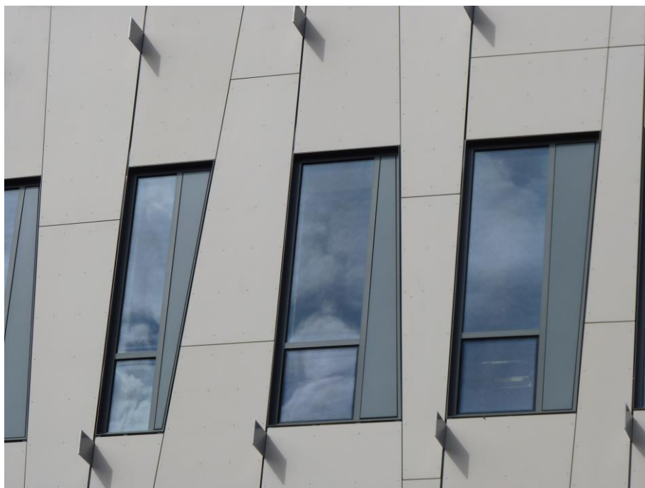
In den meisten Teilen der Fassade war Glas mit Vogelschutzeigenschaften ohne jede Beeinträchtigung der Durchsicht gefordert. Fotos: Arnold Glas.
