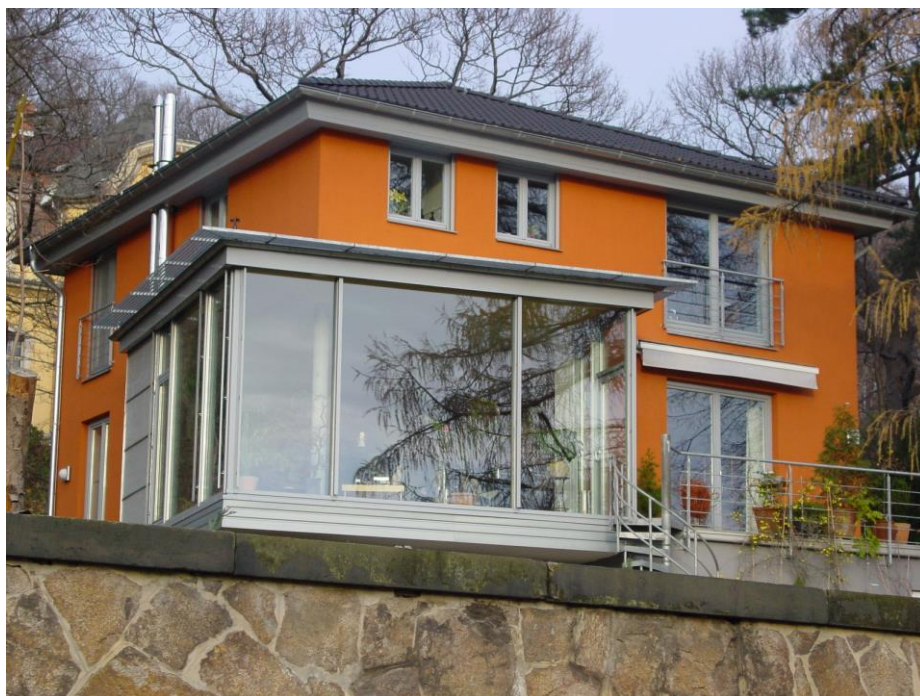
Auch bei solchen Metall-Glas-Konstruktionen muss die Verglasung absturzsicher ausgeführt werden.
