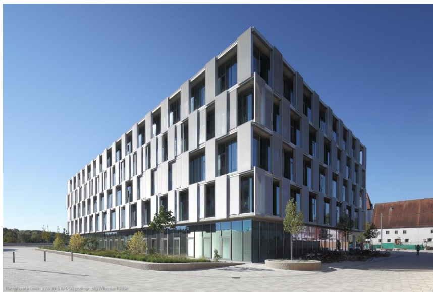
Audi Akademie, Ingolstadt. Die Fassade des Gebäudes wurde mit zwei Sonnenschutzglas Typen ausgestattet. Im Erdgeschoss ist Infrastop Brillant 70/35 eingesetzt, ein Glas welches mit seiner hohen Lichtdurchlässigkeit von 70 Prozent die im Erdgeschossbereich liegenden Räume optimal beleuchtet. In den oberen Geschossen entschieden sich die Architekten für das Sonnenschutzglas Infrastop Brillant 50/25. Neben seiner geringen Gesamtenergiedurchlässigkeit von 25 Prozent hat dieser Glastype die Architekten aus optischen Gründen überzeugt. Foto: Flachglas Markenkreis/RADON photography/Norman Radon
