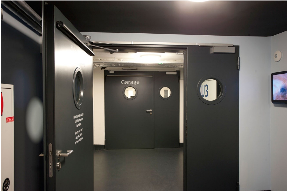
Zweiflügelig Tür mit Bullauge und Obentürschließer für einen besonders breiten Durchgang: Anlieferung im Scandic. Fotos: Teckentrup
