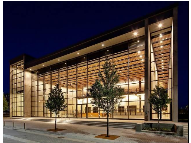
Dallas City Performance Hall – Große Stützweiten in der Glasfassade, ermöglicht durch lasergeschweißte Kastenprofile. Fotos: Technical Glass Products
