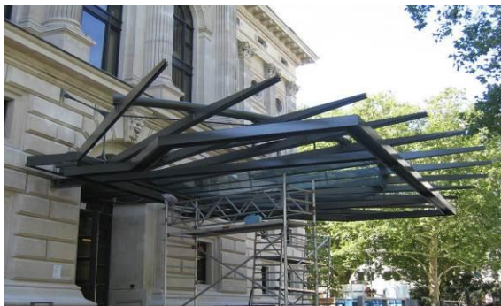
Im Vordach der Alten Oper Frankfurt wurden Glas tragende Hutprofile verbaut, die im Verlauf an Höhe verlieren. Die Untergurte, der im Lichtkranz genutzten Kastenprofile wurden eingerückt um das Beleuchtungssystem direkt einbringen zu können. Fotos: Zoth
