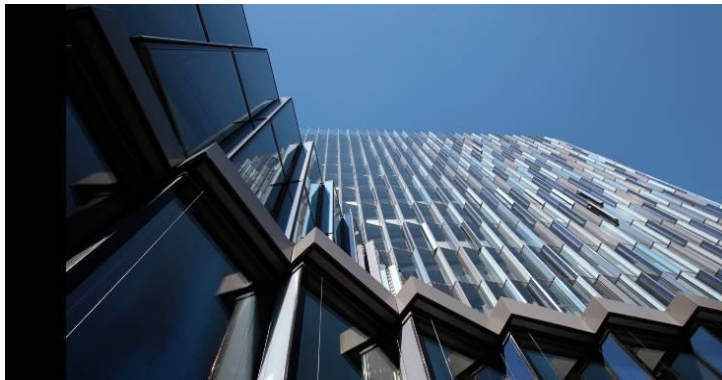
Lasergeschweißte Kastenprofile in der Westarkade der KfW Bank Frankfurt. Fotos: KfW Bank Frankfurt
