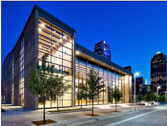
Dallas City Performance Hall – Große Stützweiten in der Glasfassade, ermöglicht durch lasergeschweißte Kastenprofile. Fotos: Technical Glass Products
