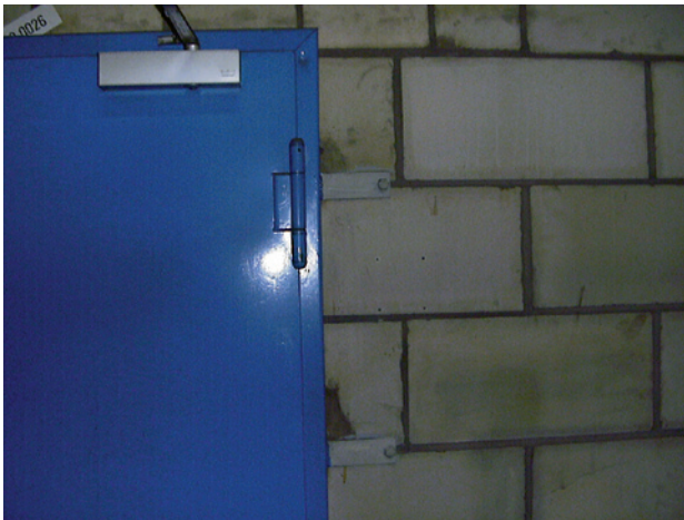
Abb. 2.61: Befestigung einer T 30-Tür in Eigen- konstruktion
