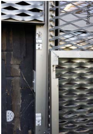
Zur Befestigung der Fassadenelemente wurden die ausgeklinkten Rahmen in vormontierte Haken eingehängt.
