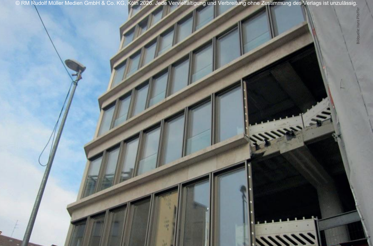
Teilansicht der Fassade mit den beanstandeten Eloxaloberflächen.
